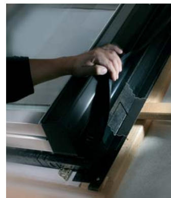
Bij moeilijk bereikbare plaatsen zorgt een voorgemonteerde warmte-isolatie voor een luchtdichte isolatie van de naden aan het kozijn.
